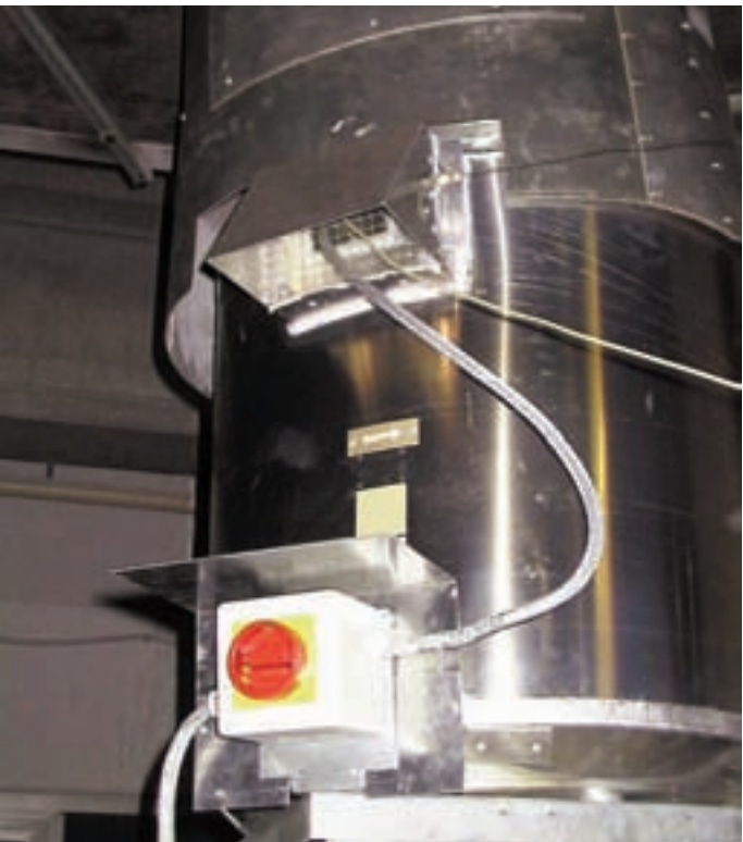
Wärmegehüteter Reparaturschalter, Kühlluftansaugstutzen
