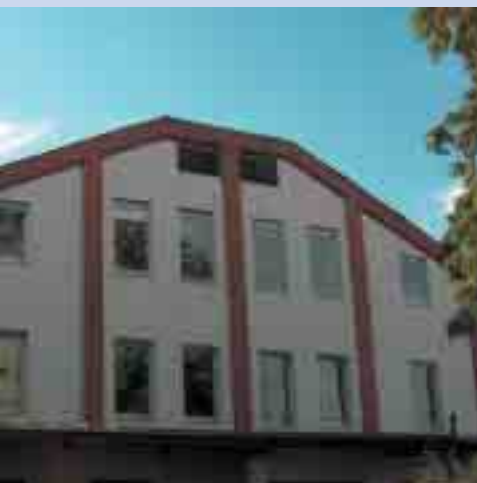
TLT-Service Stützpunkt in Frankenthal
